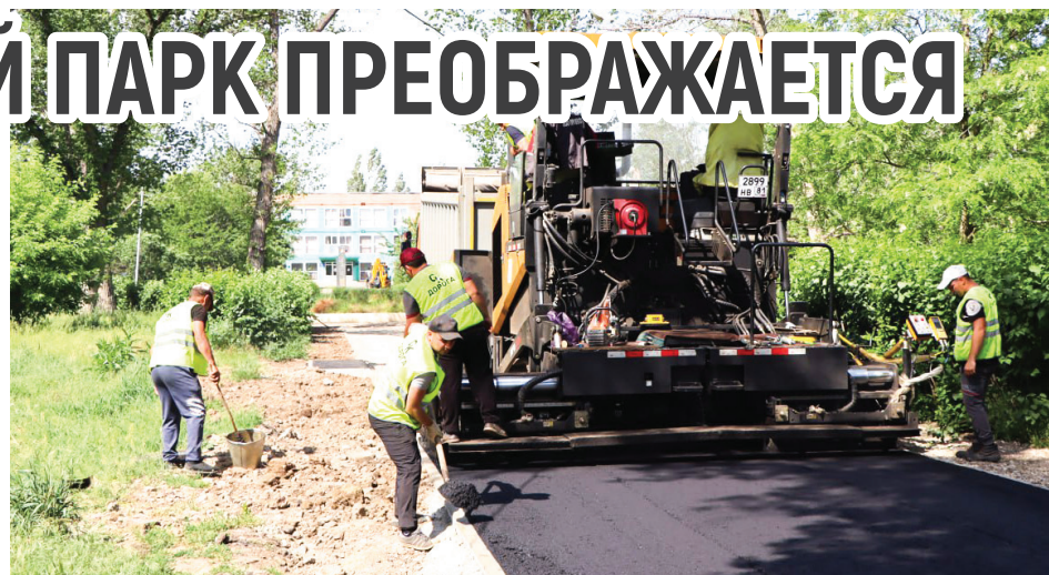
Специалисты ООО «СК «Дорога» выполняют замену асфальтового покрытия
