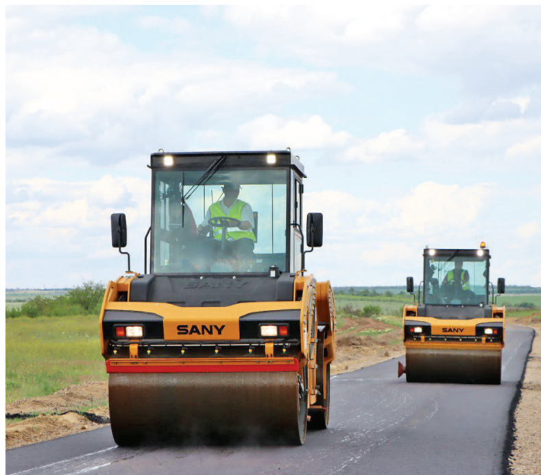
Специалисты ООО «СК «Дорога» укладывают асфальтовое покрытие
