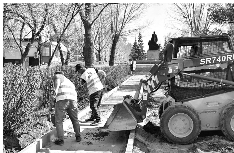
Специалисты ООО «СК «ДОРОГА» проводят ремонтные работы тротуара
