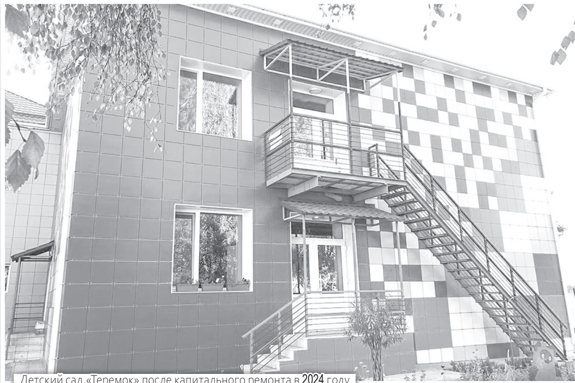
Детский сад «Теремок» после капитального ремонта в 2024 году
