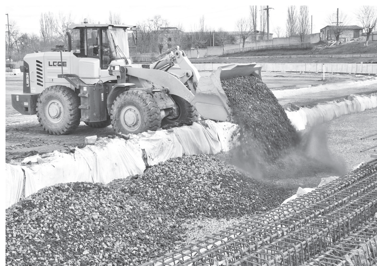
Подготовка основания для новых трибун
