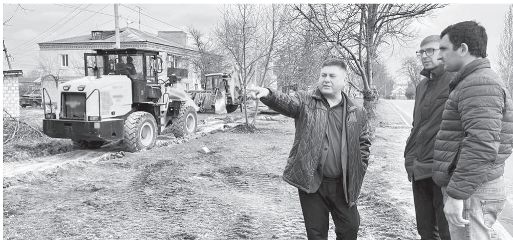
► По итогам декабрьского общественного голосования 2024 года начались работы по благоустройству аллеи в квартале Молодежном
