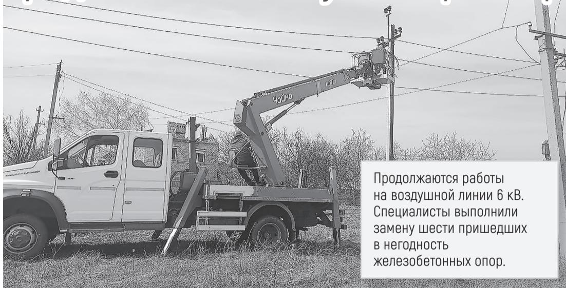
Продолжаются работы на воздушной линии 6 кВ. Специалисты выполнили замену шести пришедших в негодность железобетонных опор.
