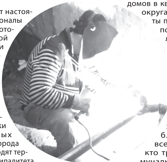
Работы по ремонту отдельных участков трубопроводов
