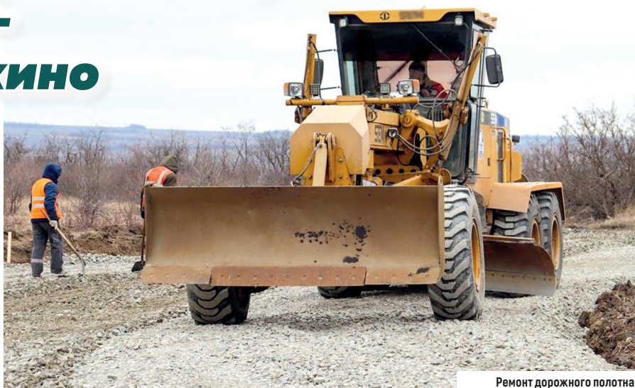
Ремонт дорожного полотна
