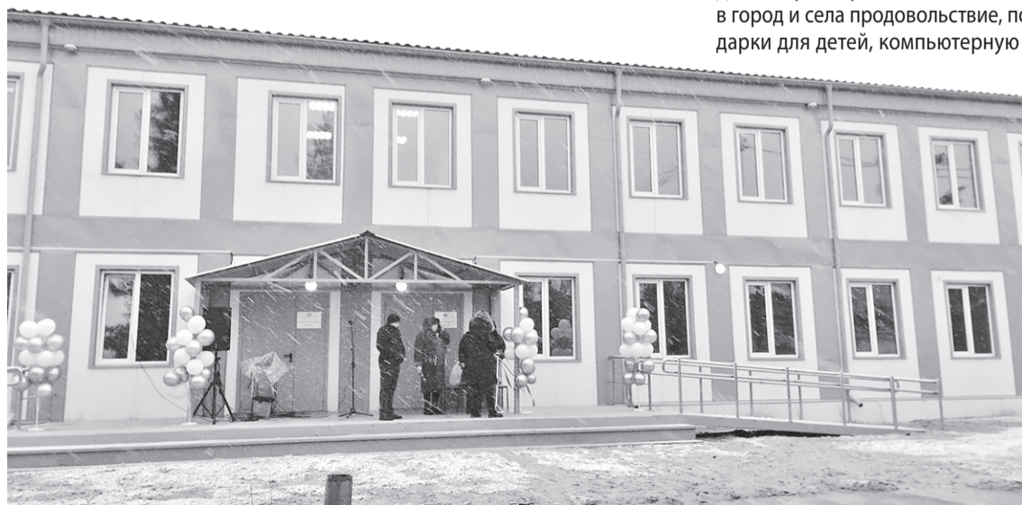
Новый корпус центральной районной больницы
