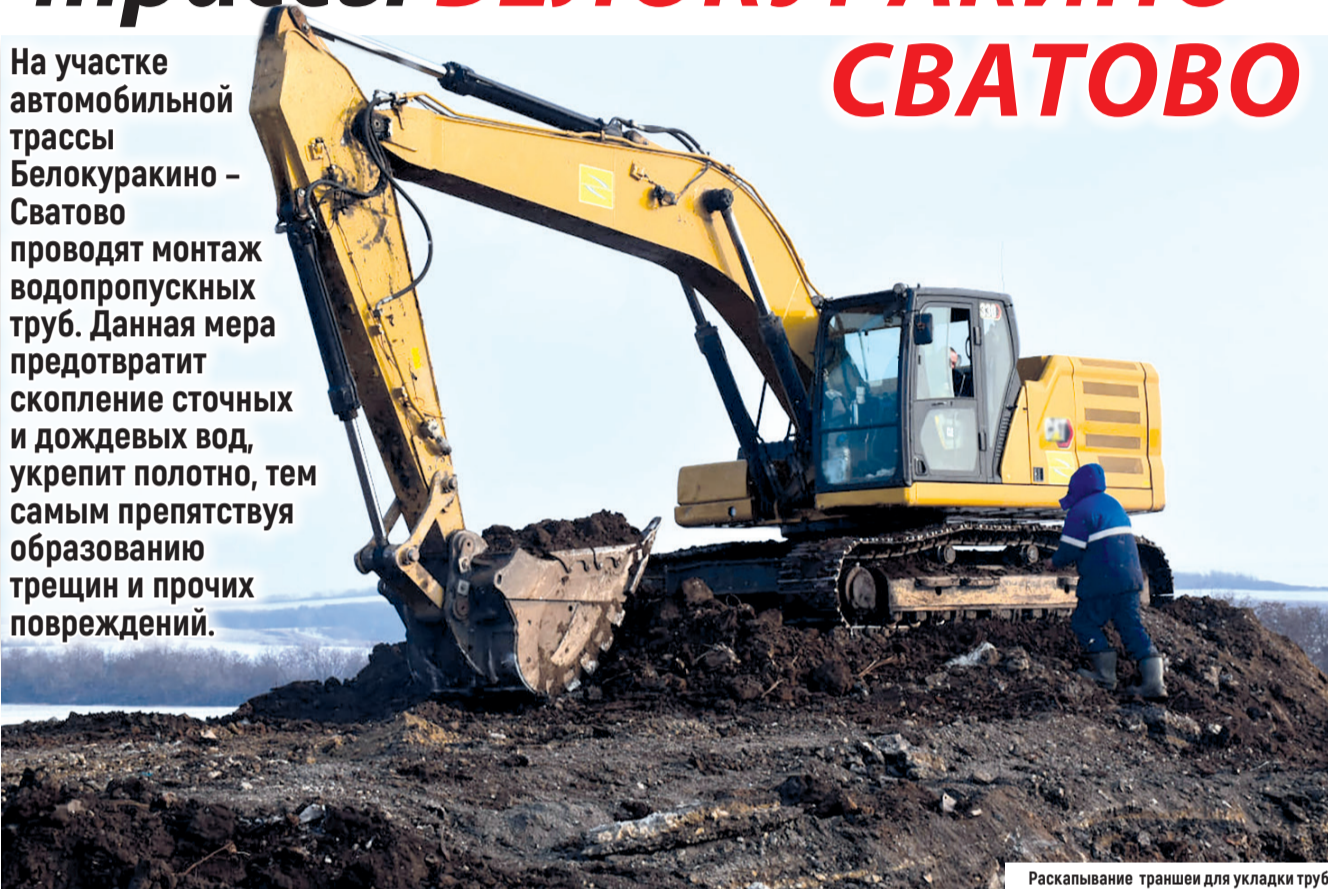
Раскапывание траншеи для укладки труб
