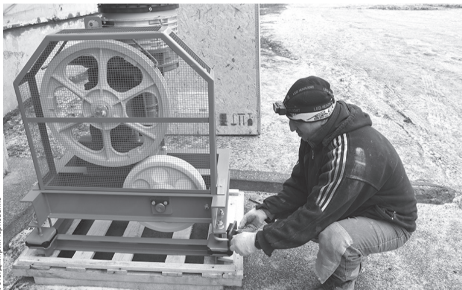
Установка нового лифтового оборудования
