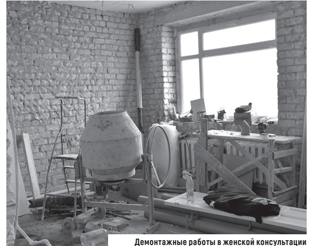
Демонтажные работы в женской консультации
