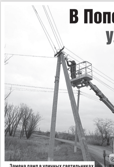
Замена ламп в уличных светильниках
