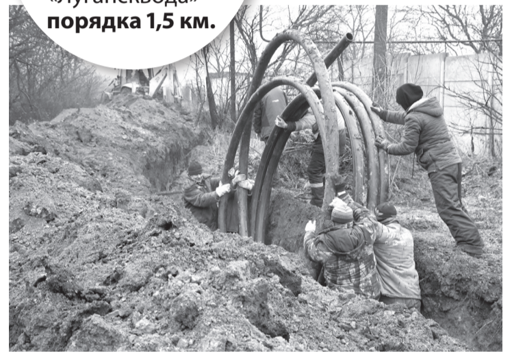
Замена аварийного участка водовода на улице Яблонево
