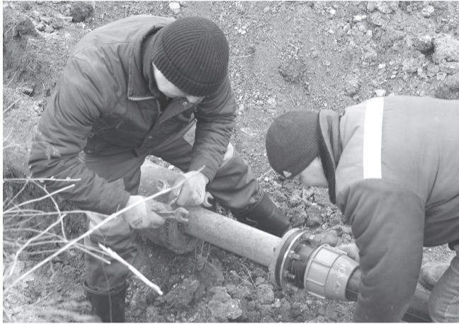
Замена аварийного участка водовода в Завадске
