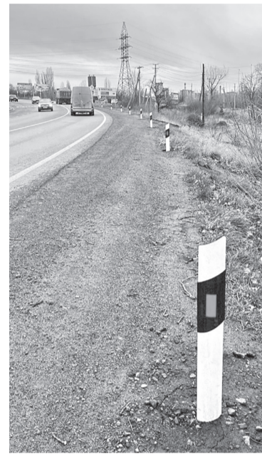
Дорожные сигнальные столбики на автодороге в Георгиевке
