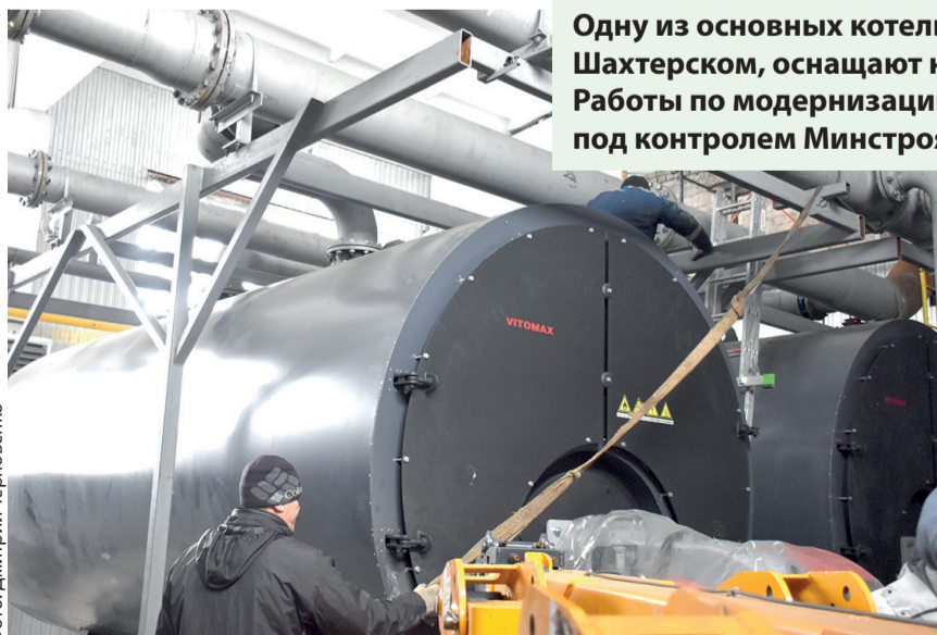
Установка новых котлов в котельной
