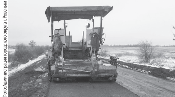
Ремонт участка дороги Ровеньки – пгт Михайловка
