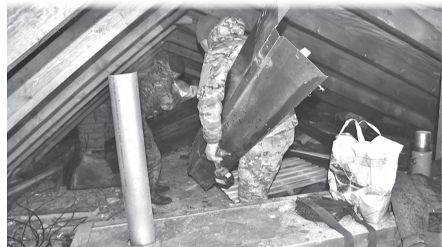
► В чердачном помещении убирали строительный мусор
