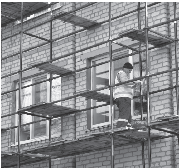
Монтаж наружных откосов в отделении хирургии
