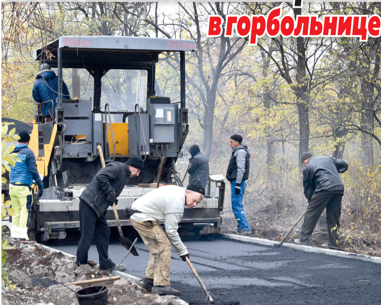
Брянские специалисты асфальтируют подъездной путь на территории горбольницы
