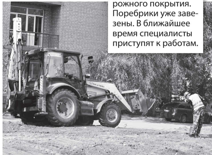
На участках, где прокладывались инженерные коммуникации, специалисты ведут планировку
