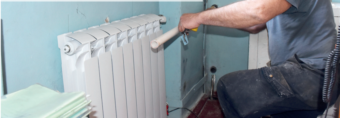
Замена системы отопления в терапевтическом отделении
