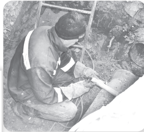
Ремонт водовода в микрорайоне № 4
