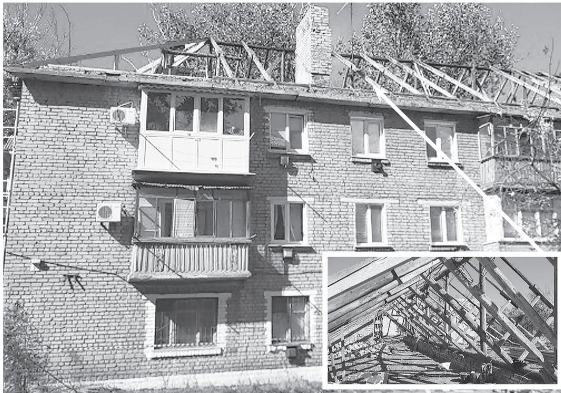
ция провела демонтаж старой и устройство новой стропильной системы и обрешетки, установила покрытие кровли из профилированного металлического листа и заменила старый чердачный утеплитель на новый из легкого керамзитобетона. В рамках проекта была установлена новая система водоотведения. Общая площадь выполненного ремонта составила 913 квадратных метров. Ремонт значительно повысил энергоэффективность здания и улучшил его внешний вид.
