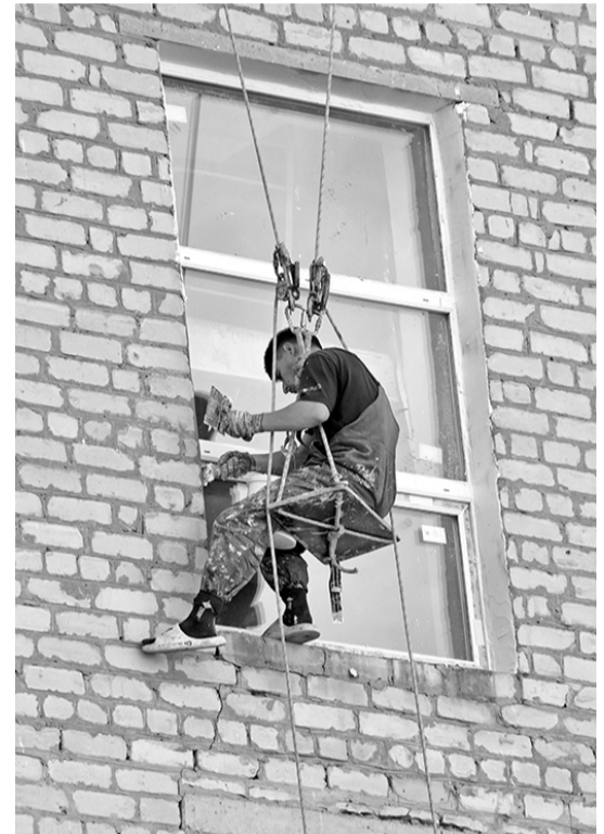
Строитель из Ульяновской области оштукатуривает наружный откос в многоквартирном доме
