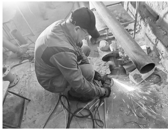
Теплотехник из Удмуртской Республики проводит ремонтные работы в Лутугинском колледже
