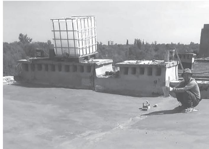
– После восстановления несущих конструкций, нанесения гидроизолирующего слоя будет произведен ремонт парапетов с отделкой их оцинкованным железом. Для контроля качества была привлечена специализированная фирма «РосКапСтрой», с которой мы в очередной раз провели инспекцию, мониторинг производства работ. Есть, конечно, некото-
