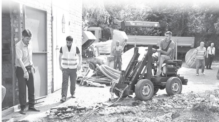
С помощью спецтехники и оборудования уже выполнены работы по обустройству земляных траншей, и на улице Макаренко уже начата укладка силового кабеля.
