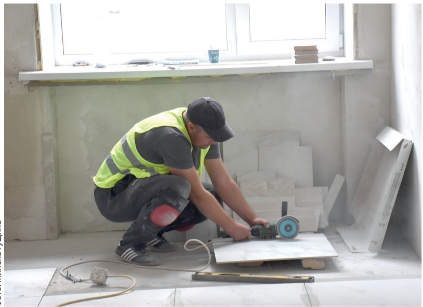
Бригада строителей подрядной организации проводит укладку нового напольного покрытия и электромонтажные работы
