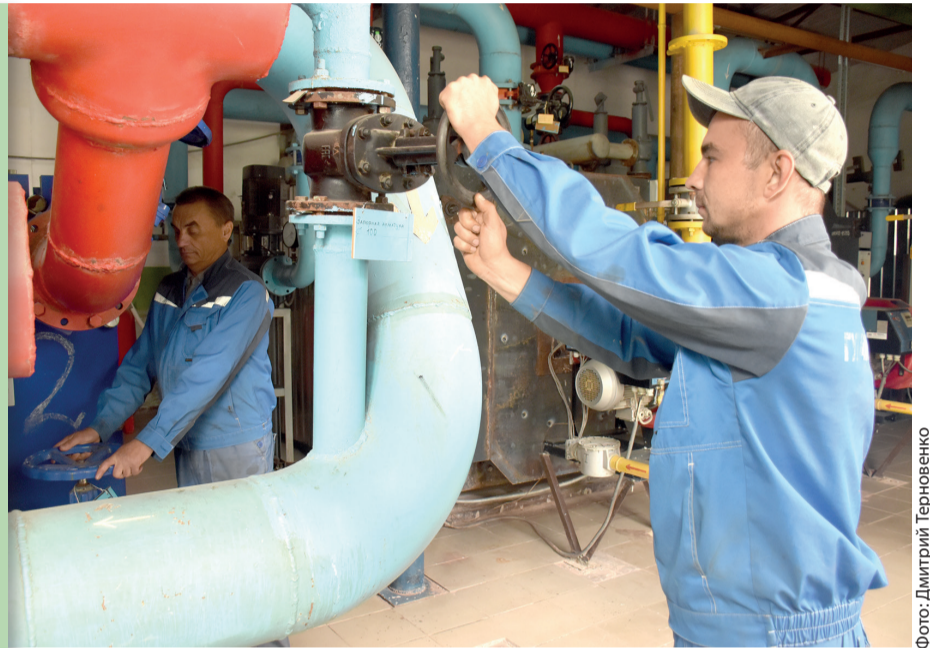
Слесари Александр Моисеев и Геннадий Басарай проверяют оборудование для подачи теплоносителя
