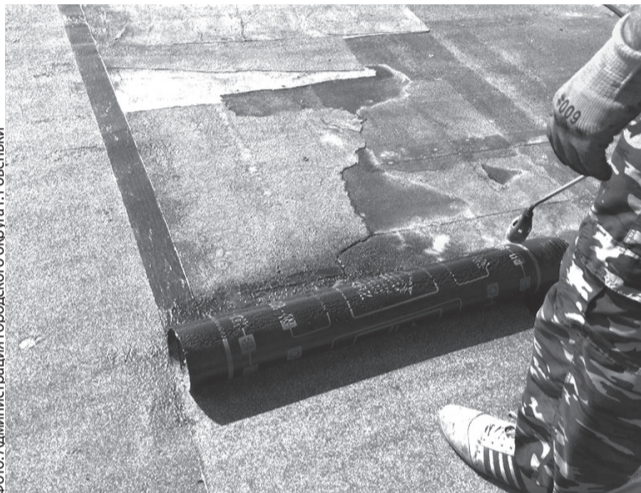
Сотрудники ООО «КОМ-СЕРВИС» проводят укладку мягкой кровли
