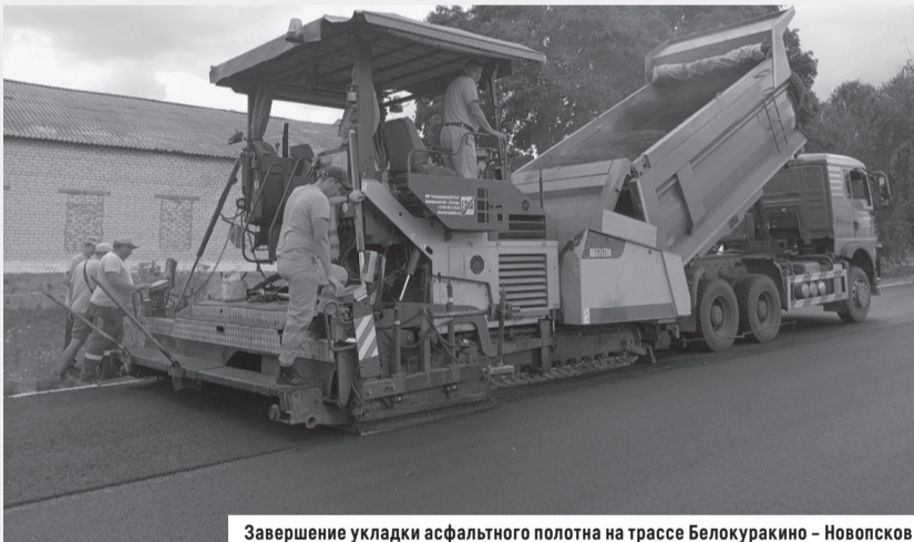
Завершение укладки асфальтного полотна на трассе Белокуракино – Новопсков
