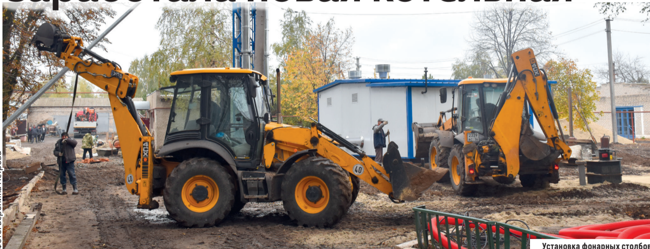
Установка фонарных столбов
