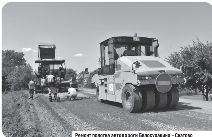
Ремонт полотна автодороги Белокуракино – Сватово
