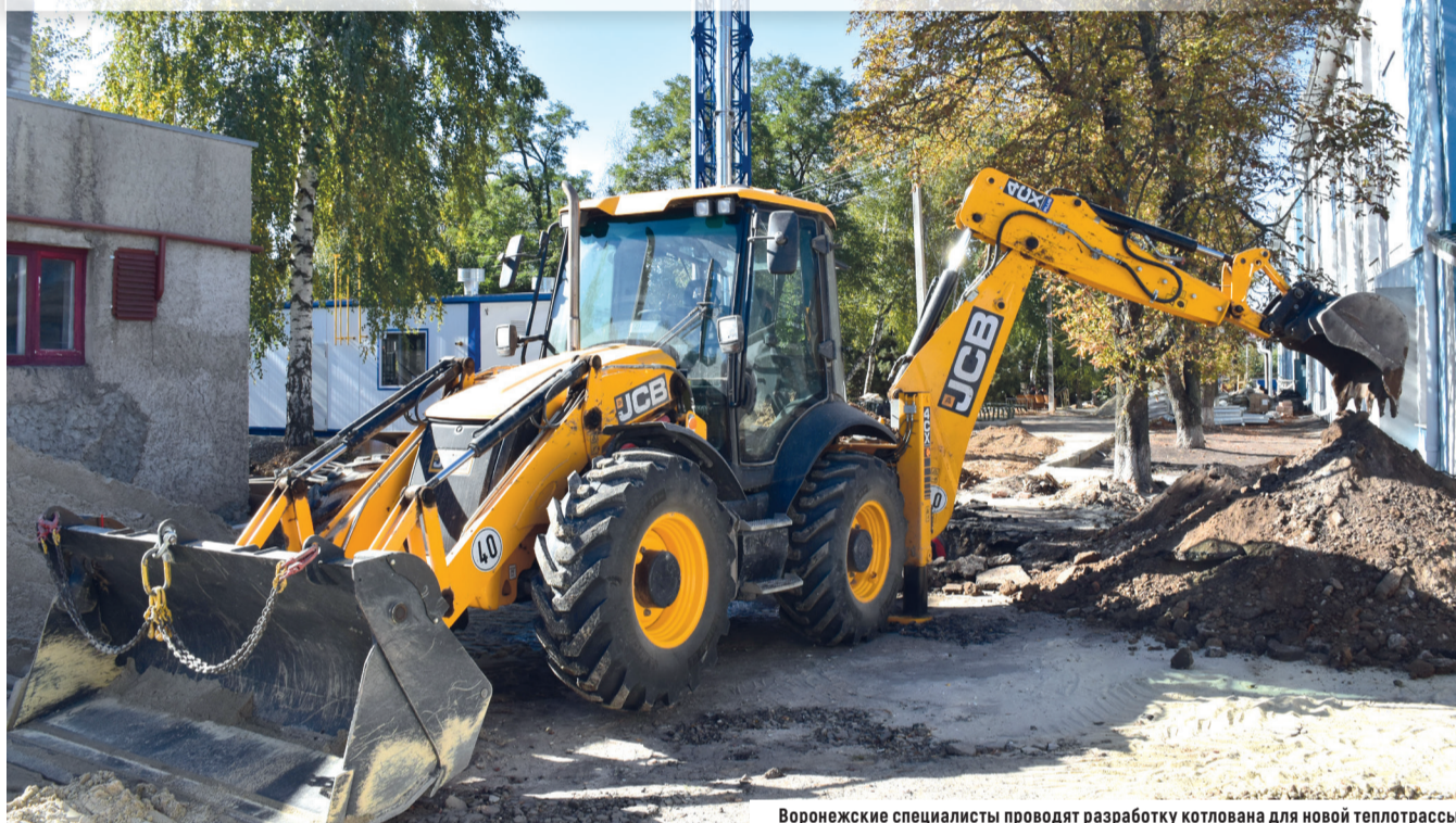
Воронежские специалисты проводят разработку котлована для новой теплотрассы
