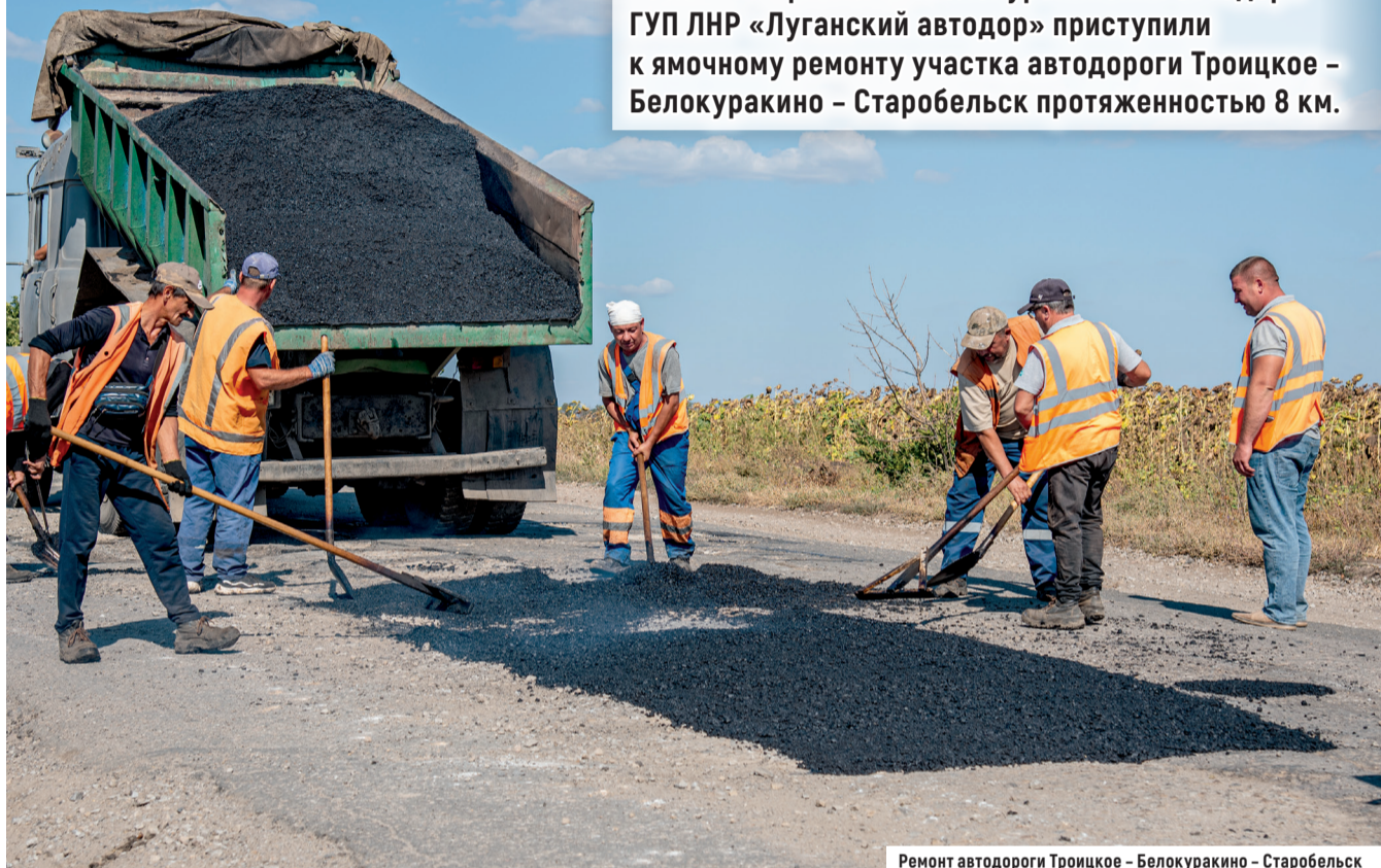
Ремонт автодороги Троицкое – Белокуракино – Старобельск
