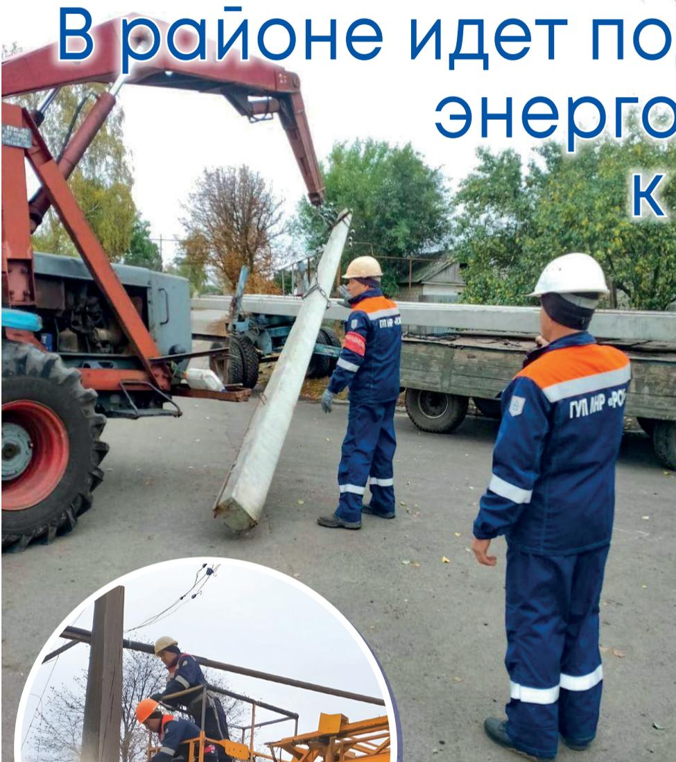
В Беловодске энергетики ведут масштабную работу по капитальному ремонту оборудования КТП (трансформаторной подстанции) и отходящих от нее воздушных линий электропередачи 0,4 кВ на улицах Некрасова и Садовой.
