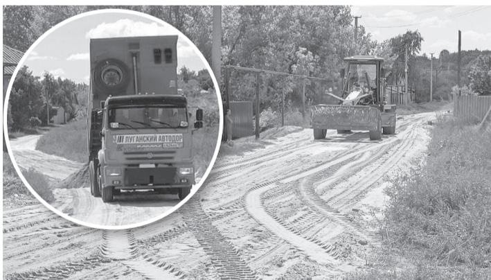
В ходе работ была проведена отсыпка мергелем и песком с последующим грейдированием и укатыванием дороги.
