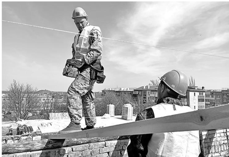
ем. Сейчас они меняют старое шиферное покрытие, снимают старую обрешетку и выполняют монтаж новой, делают частичный ремонт стропильной системы на шатровой кровле. На плоской кровле проходит демонтаж старого покрытия, монтаж утеплителя, стяжки и сверху – нового покрытия.
