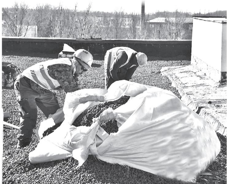
– На объекте проходит капитальный ремонт кровли площадью около 1 200 кв. м. На сегодня строители выполнили демонтаж и разуклонку кровли из керамзита. После они уложат на керамзит в два слоя цементно-стружечные плиты и примутся за капитальный ремонт парапета, – добавил Степан Михайлович.
